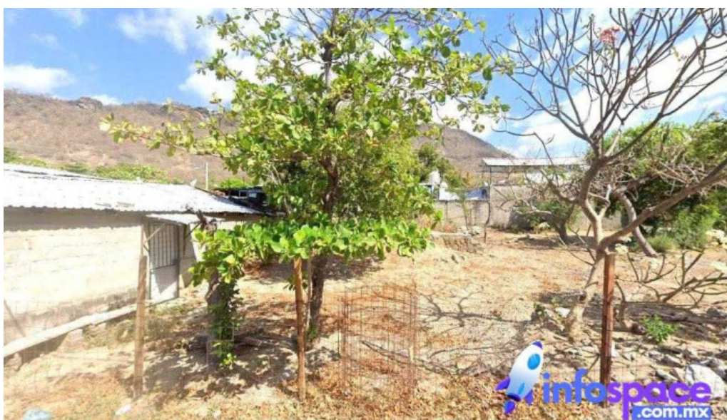
Edificio municipal santa maria mixtequilla
