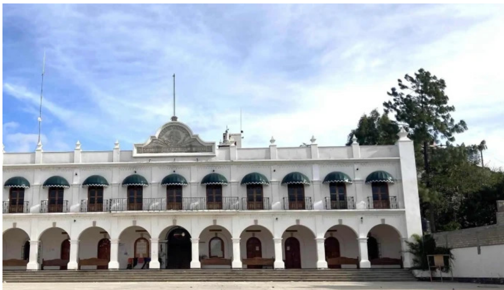
Edificio municipal san andres zautla zautla
