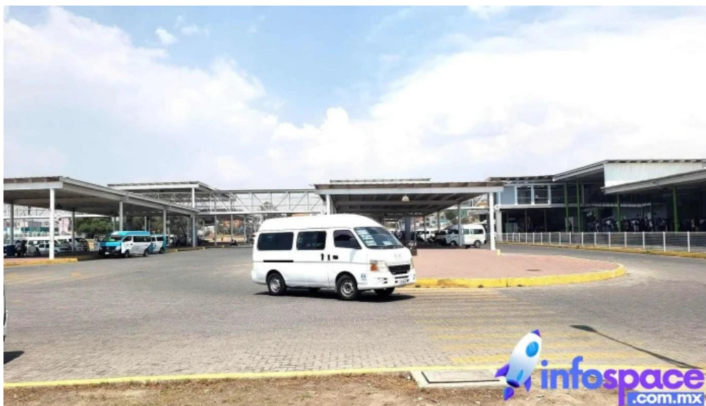
Terminal mexibus ojo de agua cerca de mi
