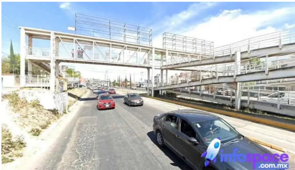
Av adolfo lopez mateos y calle del puente san bernardino tlaxcalancingo
