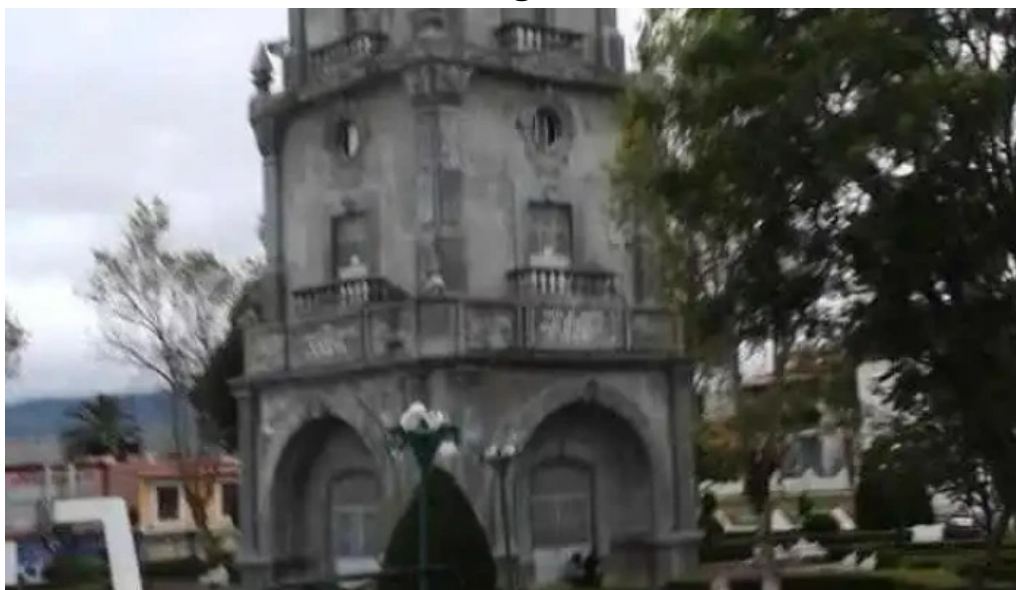
Santiago yolomecatl santiago yolomecatl
