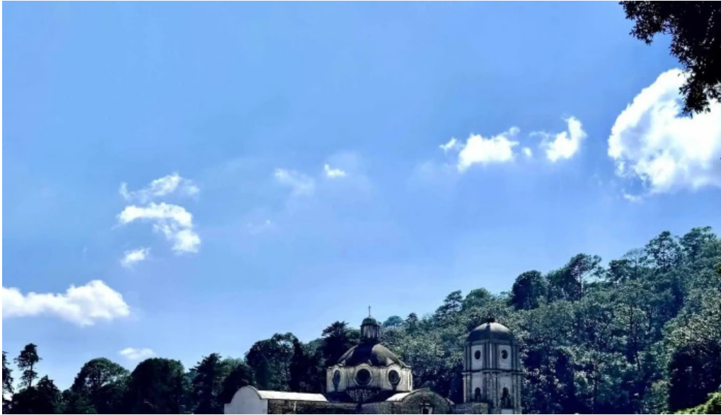
Convento del desierto del carmen zona
