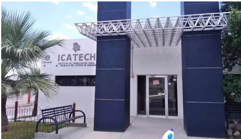
Icatech camargo edificio
