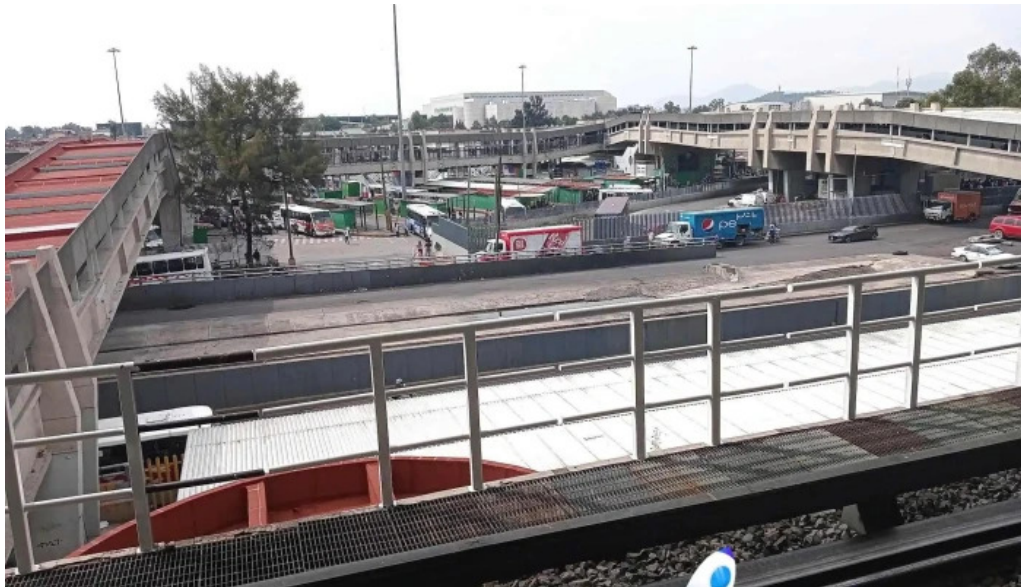
Cetram pantitlan estacion de ferrocarril
