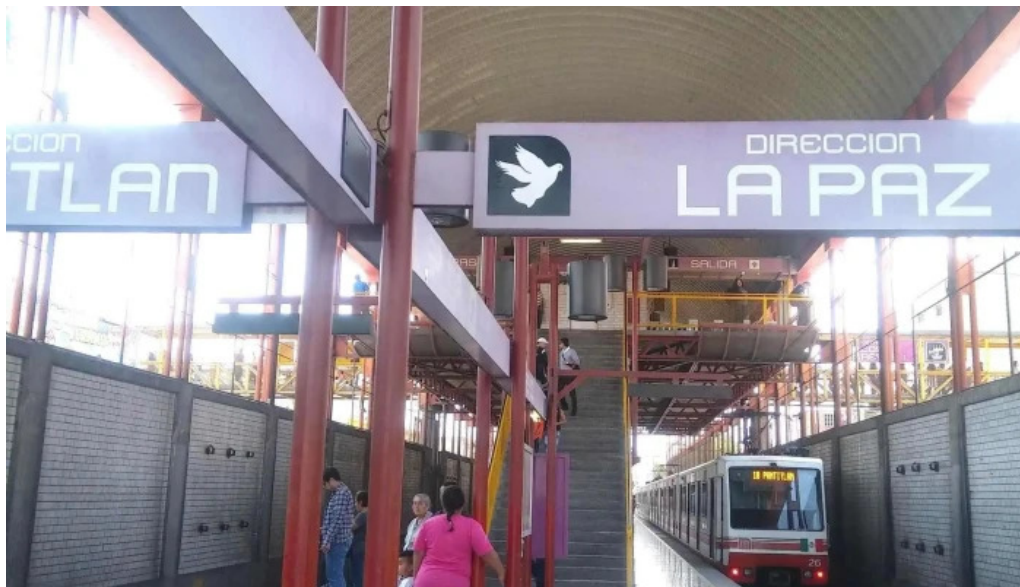
Los reyes parada de tren subterraneo
