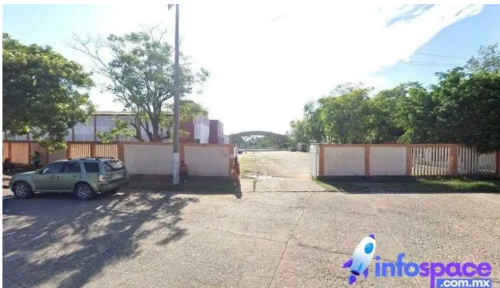
Terminal de autobuses lazaro cardenas cdad lazaro cardenas
