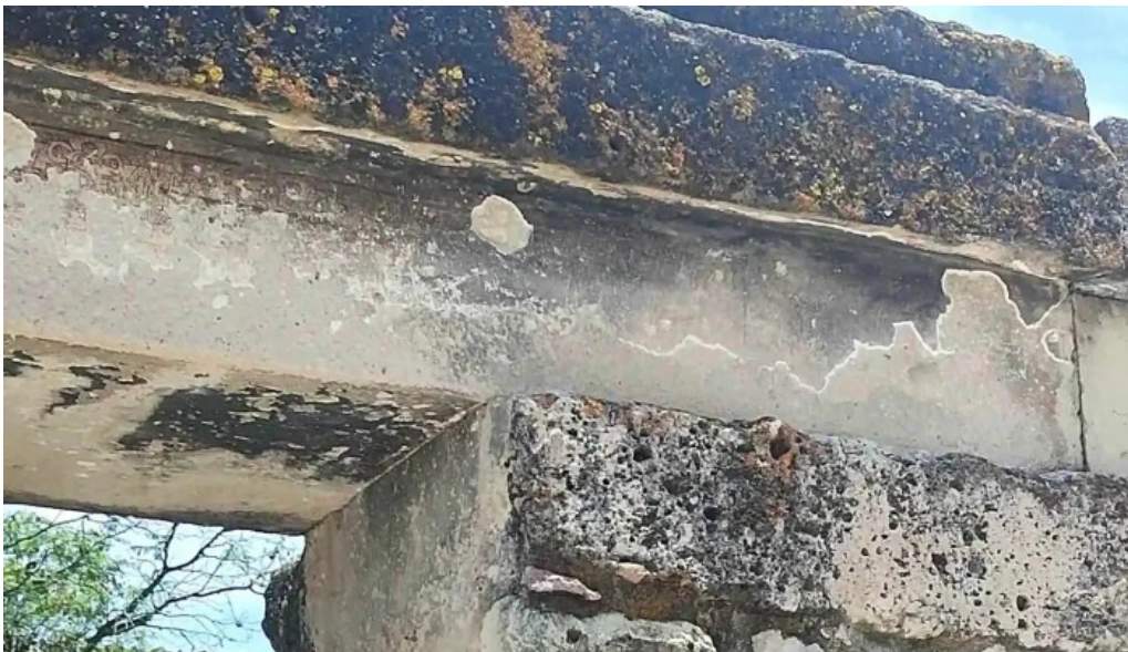
Grupo del arroyo za de mitla sitio web
