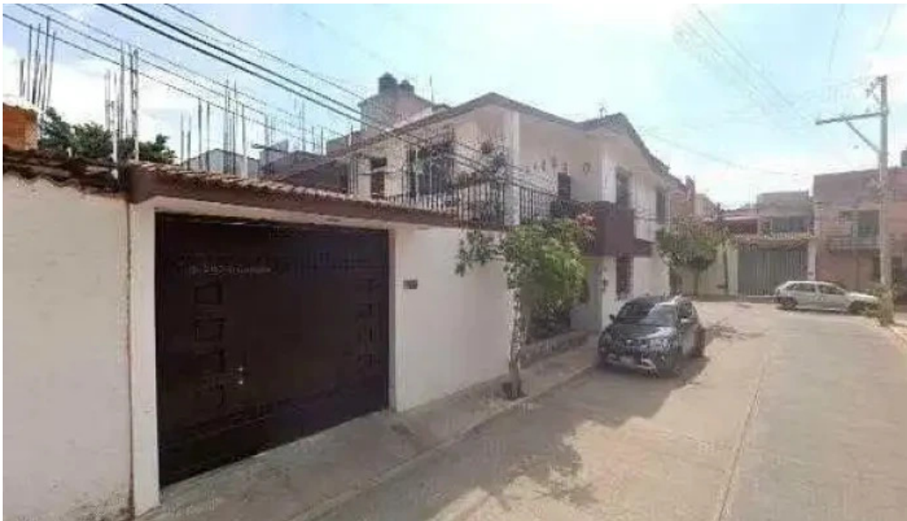
Pidc consultoria sas de cv comentariosdeg
