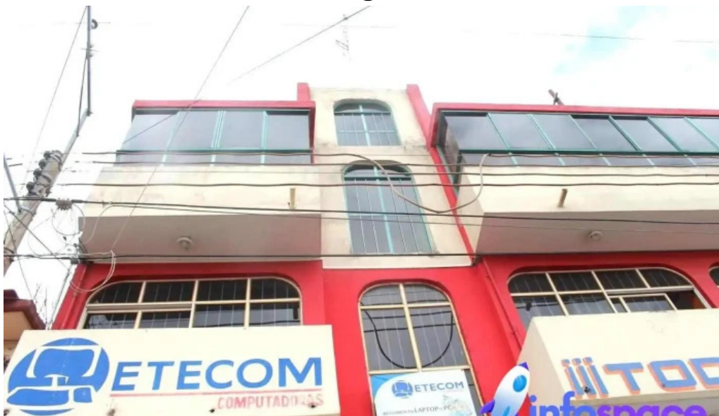
Etecom telecomunicaciones villa de etla
