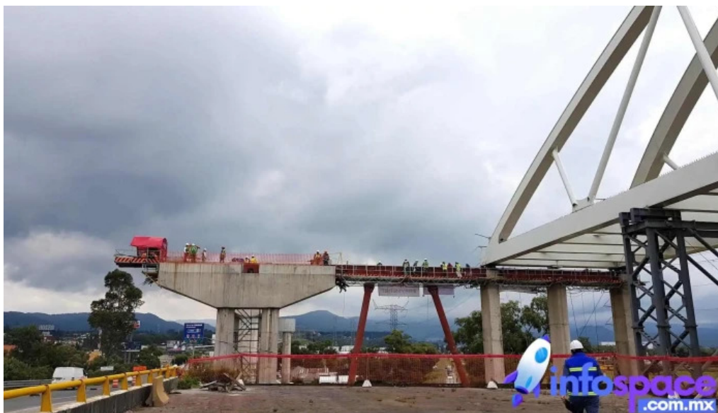
Puente arco tren interurbano mexico toluca la peninsular cia constructora descuentos
