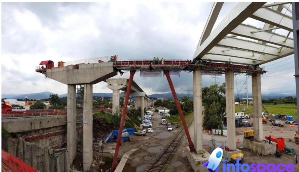
Puente arco tren interurbano mexico toluca la peninsular cia constructora puente
