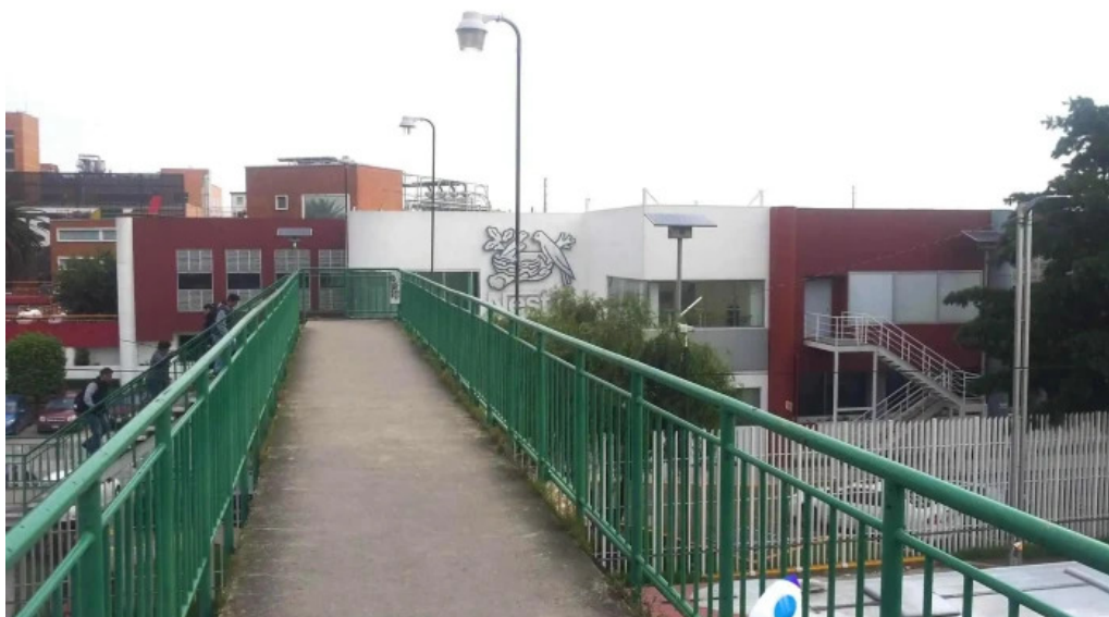
Puente peatonal a la altura de nestle puente
