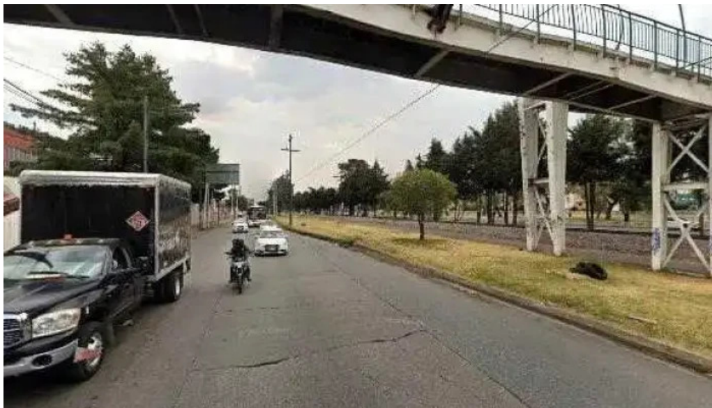
Puente peatonal a la altura de nestle direcciondeg
