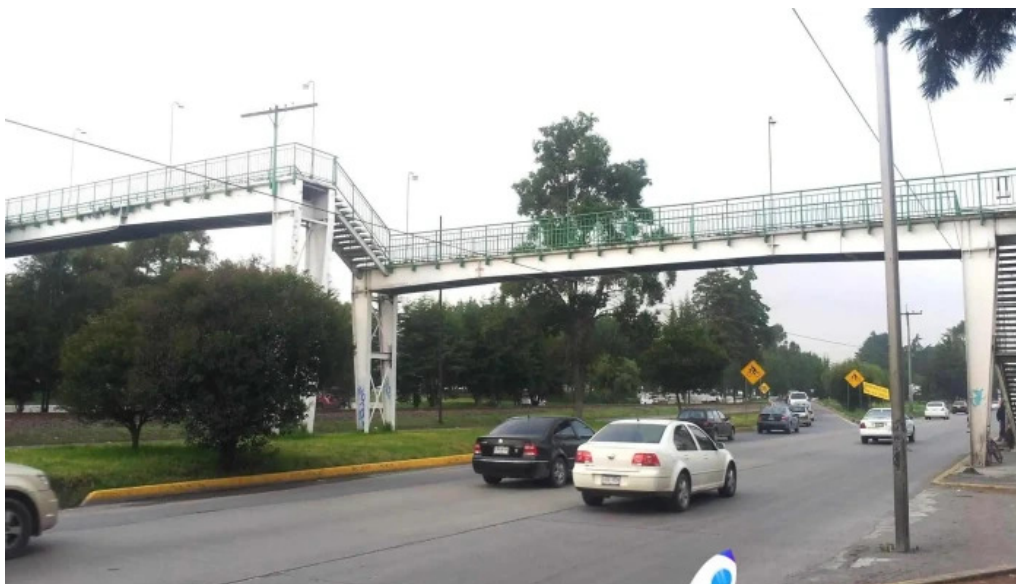
Puente peatonal a la altura de nestle direccion
