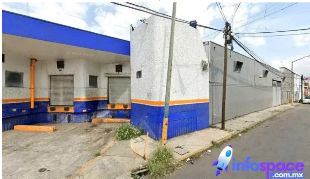
Mexicana de terminales en puertos y aeropuertos sa de cv venustiano carranza ciudad de mexico
