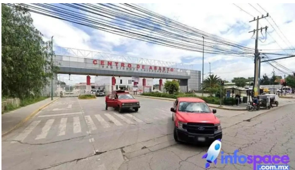
Estacion mexibus central de abastos de chicoloapan chicoloapan de juarez
