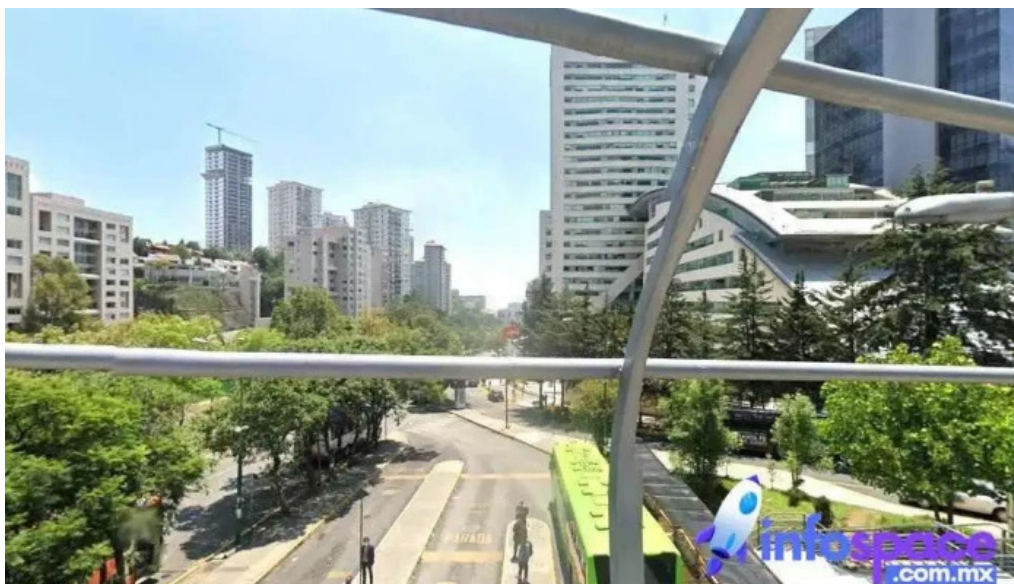
Rtp terminal c c santa fe cuajimalpa de morelos ciudad de mexico
