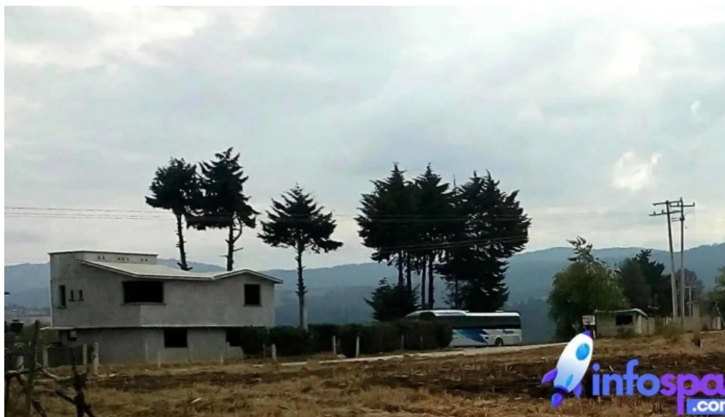
Terminal autobuses pegaso estado de mexico
