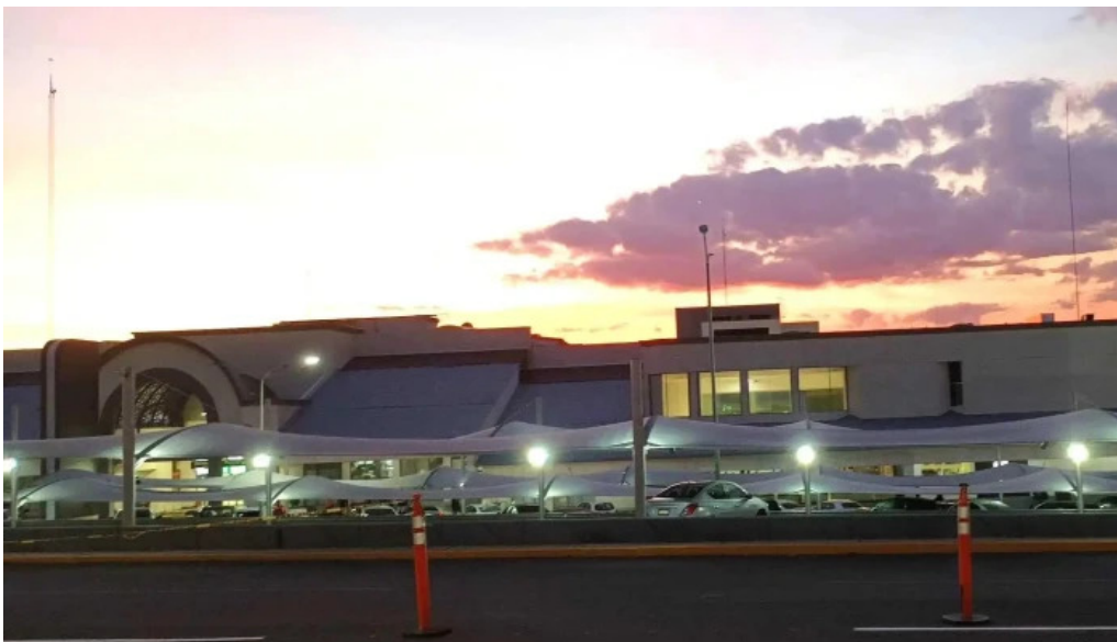
Terminal de autobuses queretaro zona
