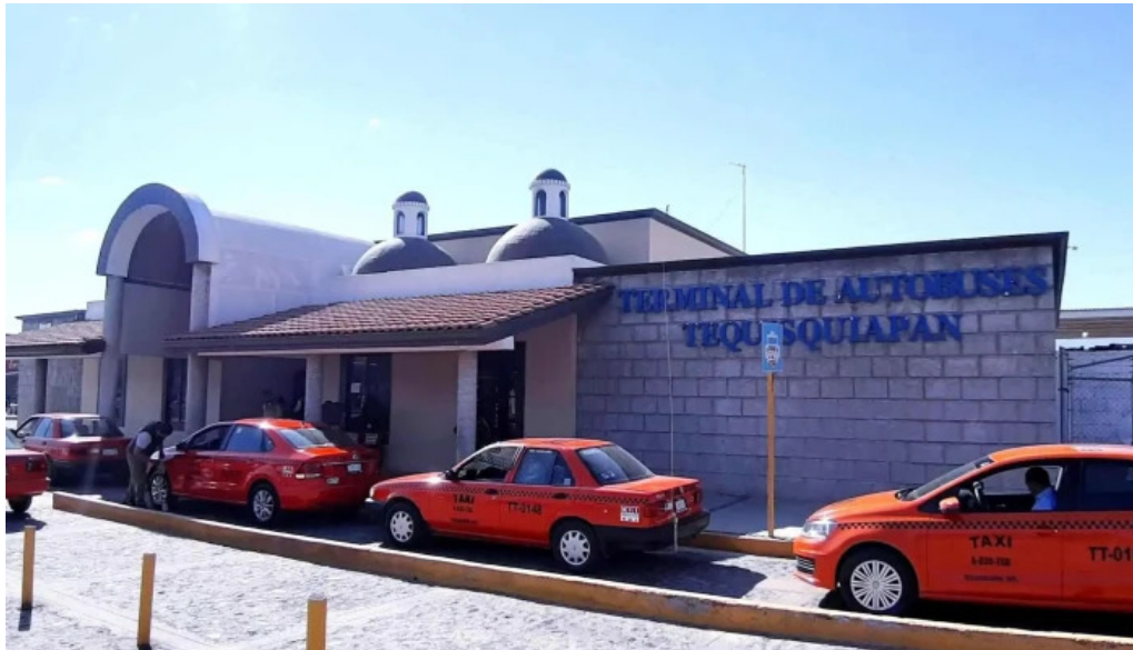
Terminal de autobuses de tequisquiapan ubicacion
