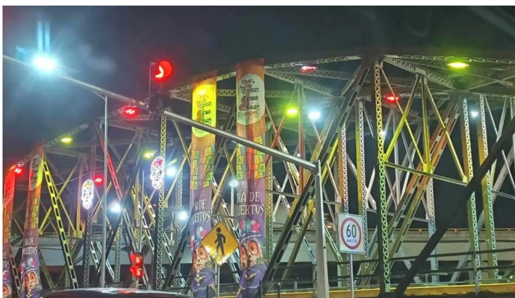
Puente de fierro descuentos
